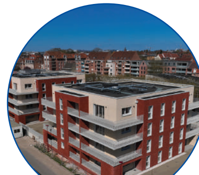
HAZEBROUCK 38 logements collectifs
