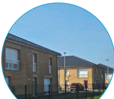
TETEGHEM 18 logements collectifs
