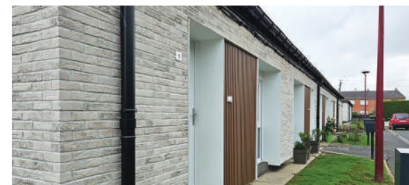
Rehabilitation Le Creuweld à Hazebrouck
